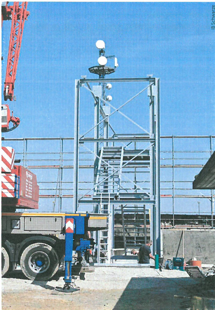
Bild 4: Errichtung der Stahlkonstruktion für die Halle
