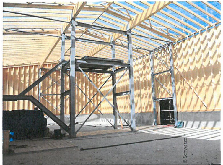
Bild 5: Holzbau und Stahlbau
