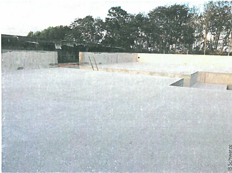
Bild 3: Neue Behältersohle mit Rohrkeller
