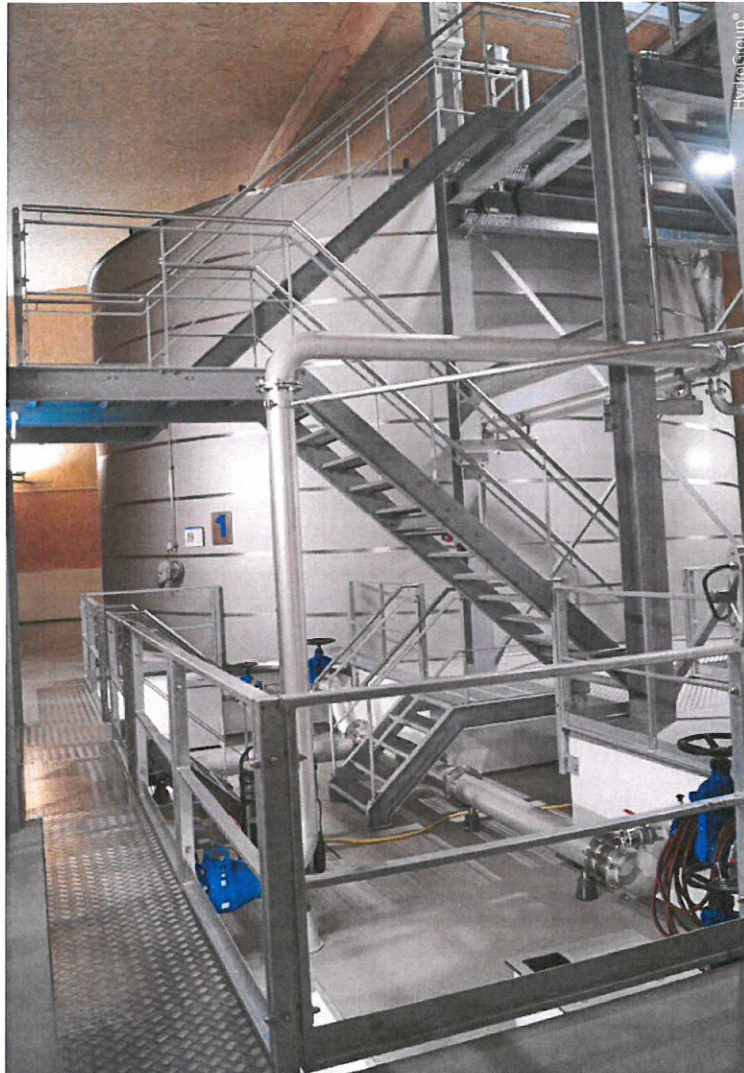
Bild 7: Treppenhaus und Behälteranlage
