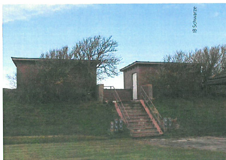
Bild 2: Reinwasserbehälter 1 und 2 von 1965
