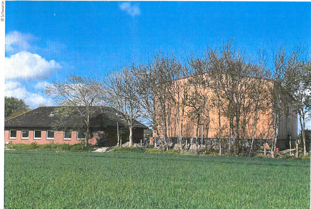
Bild 1: Druckerhöhungsstation mit neuer Speicheranlage
