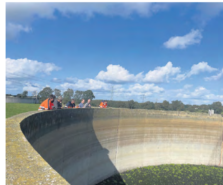
Der Weg zum Zertifikat für das Technische Sicherheitsmanagement führte nicht nur durch viele Akten, sondern auch über die Anlagen des Verbandes.
