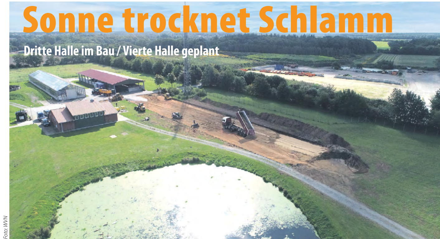
Deutlich zu erkennen ist hier das Baufeld für die neue Halle in Handewitt. Sie wird 17 Meter länger und 5 Meter breiter als die bisherige (Glasbau links).
