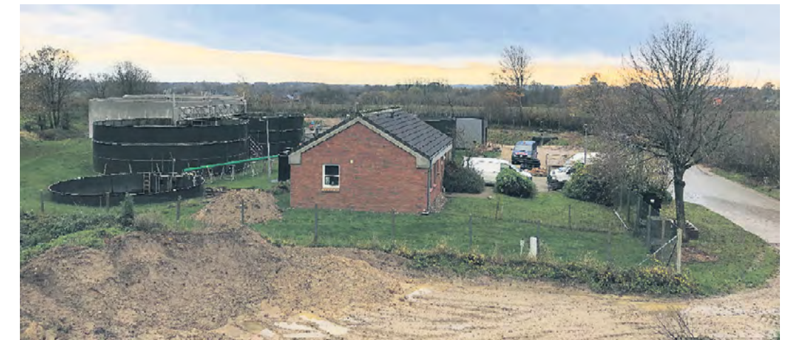
Beim umfangreichen Um- und Ausbau bleibt fast nichts beim Alten. Auf dem Areal der Kläranlage Freienwill werden vorhandene Anlagen umgenutzt und zusätzliche Anlagenteile errichtet.
